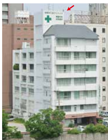
建物外観、屋根飾りはエレベータ棟の上(矢印)
