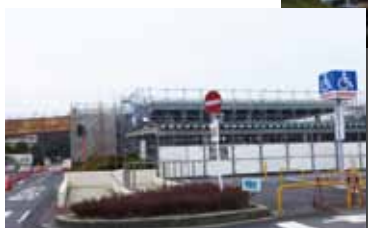
ヘリポートと病院への 渡り廊下(工事中)
