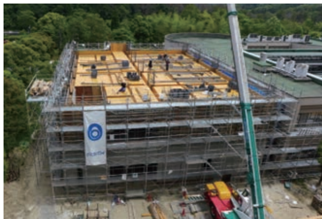
工事中の総合研究棟(疫学研究拠点)(右は図書館、臨床研究棟から)
