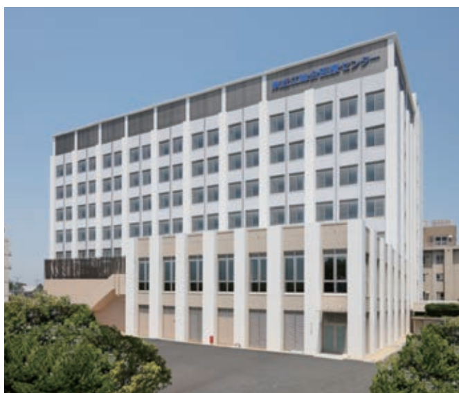
病院外観(南東面)
