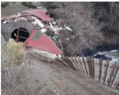
鉛のように捻じ曲げられた軌道
